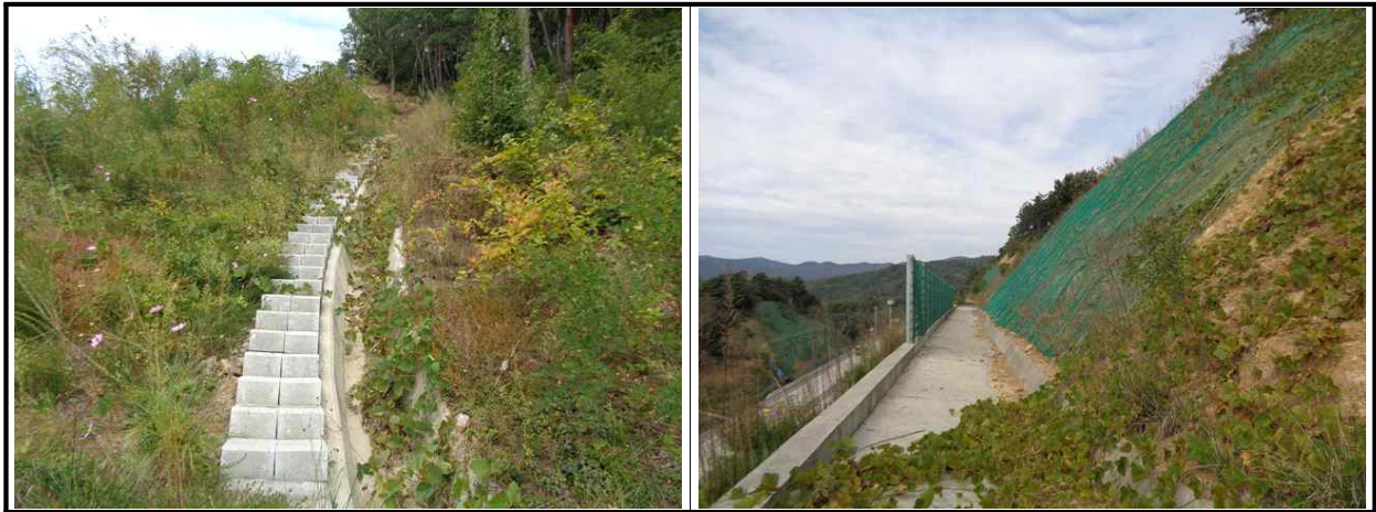
【그림 29.3.3】 배수시설 전경
